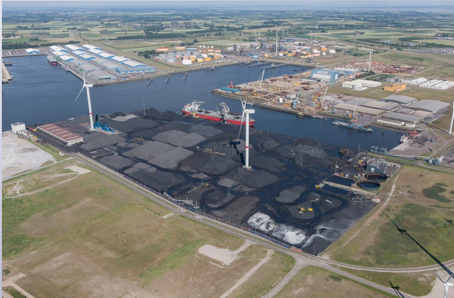
Terminal Kalloothaven Vliissingen
